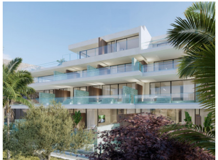
Vistas a la fachada
